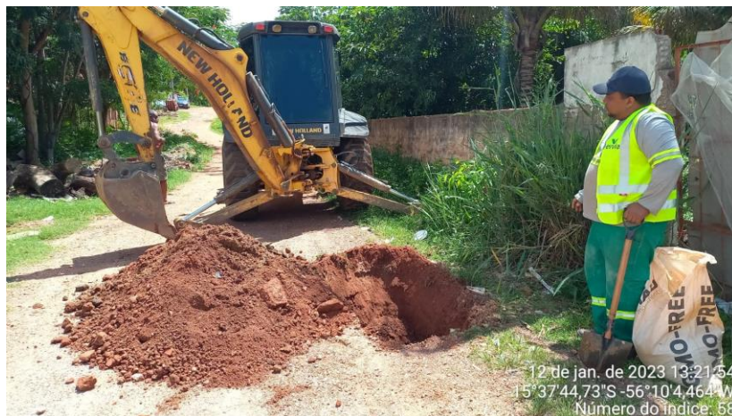
Coleta dos furos de sondagem
