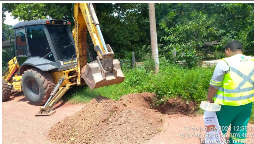
Coleta dos furos de sondagem
