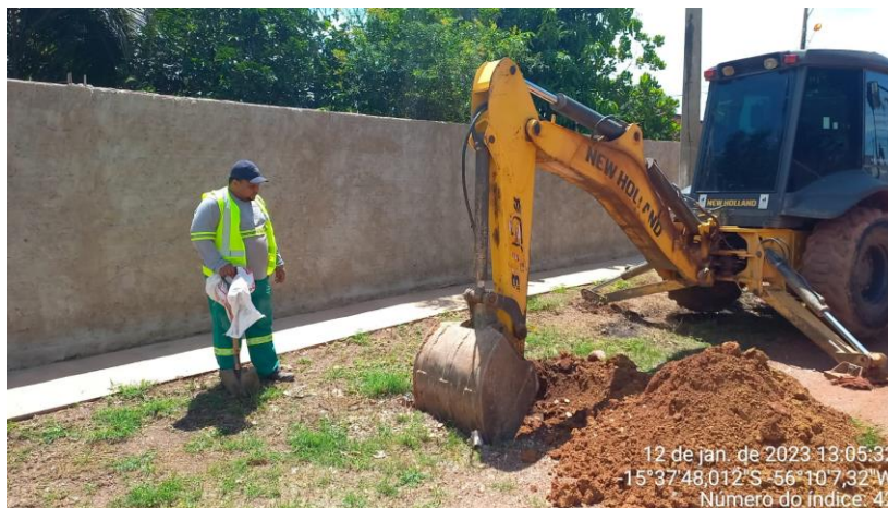
Coleta dos furos de sondagem
